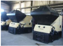
暖房用の高効率ボイラー(数理計画/モンゴル)サイト①
